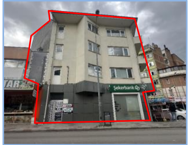
Bina (lojman katları) Girişi ve Cephe Görünümü
