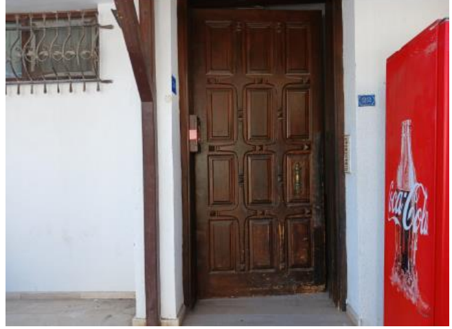
Arka Cephe Giriş Kapısı
